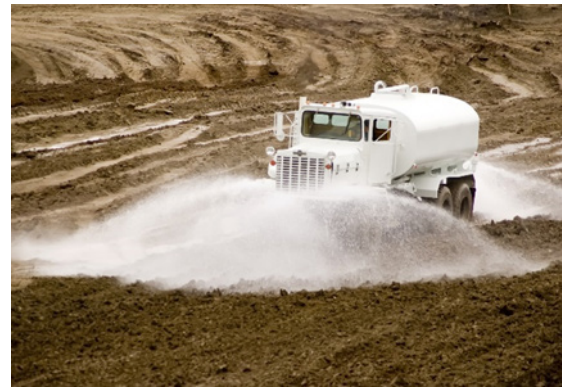
Se aplicará agua al depósito de tierra y otras áreas activas de trabajo para controlar el polvo
